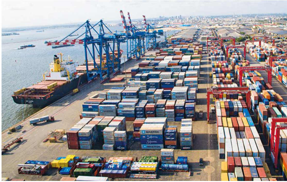
Abidjan Terminal (terminal à conteneurs), un des premiers ports d'Afrique avec une capacité annuelle de 1,3 million EVP.
