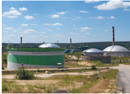
Cuves de stockage de produits pétroliers, dépôt de Rouen Petit-Couronne.
