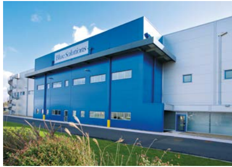
L'usine Blue Solutions de production de batteries LMP® à Quimper en Bretagne.
