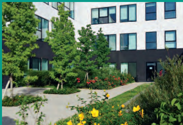
Le Green Hub de Roissy, labellisé BiodiverCity® et certifié HQE* « Exceptionnel », LEED® « Gold » et « Bâtiment biosourcé » certifié Engagement Biodiversité par Ecocert.
